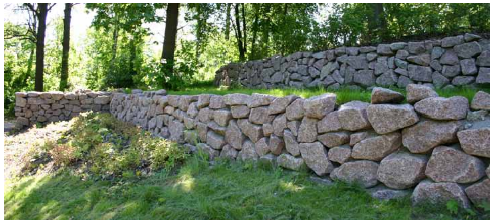
Kuva 10. Luonnonkivilouhimon sivukivi soveltuu niin ympäristö- (oikealla) kuin vesirakentamiseenkin (alla). Kuvat: Palin Granit Oy.
