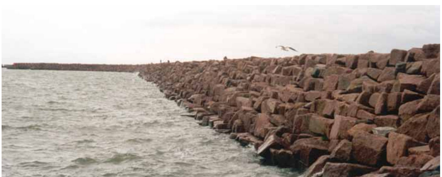
Kuva 10. Luonnonkivilouhimon sivukivi soveltuu niin ympäristö- (oikealla) kuin vesirakentamiseenkin (alla). Kuvat: Palin Granit Oy.
