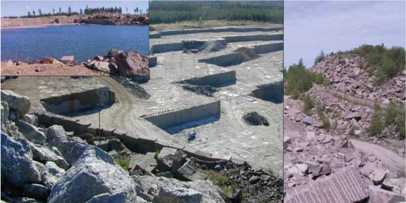
Kuva 1. Luonnonkivilouhimon erityispiirteitä ovat jyrkät ja pysyvät seinämät, pysyvät vaakatasot eli terassit, tiivis ja ehyt pohja, vesiallas ja sivukivikasat. Kuvat: Olli Breilin, Paavo Härmä ja Pekka Sipilä.
